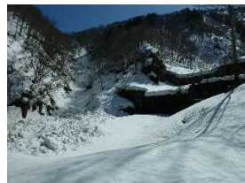
⑦北東尾根への入口堰堤付近
